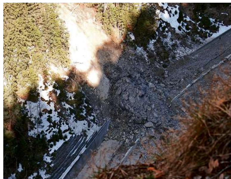
Spezialisten von Crestageo machen den Weg frei, oben die mit ca. 1000 Kubikmeter verschüttete Strasse, unten ein Bild nach der Sprengung des Felsblocks.
