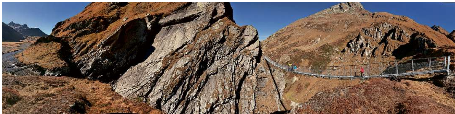
Die alte und die neue Brücke auf einen Blick: In zwei Jahren muss der alte Übergang zum Muot la Greina entfernt werden. (FOTOS NORBERT WASER)
