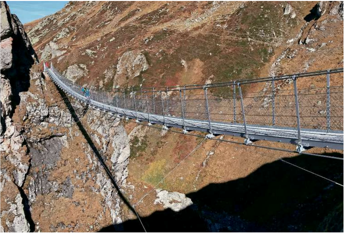
Punt la Greina: Eine 65 Meter lange Hängebrücke überspannt den Rein da Sumvitg . (FOTO NORBERT WASER)
