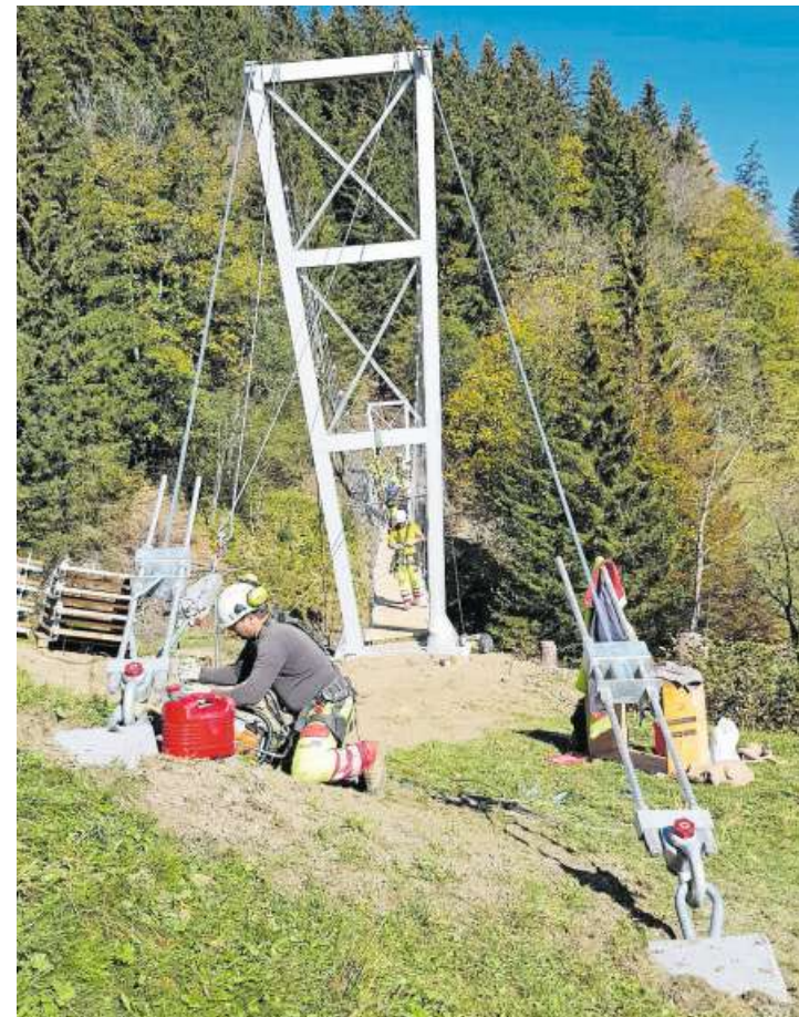
Die Tragseile werden über zwei rund acht Meter hohe Pylone gespannt.
