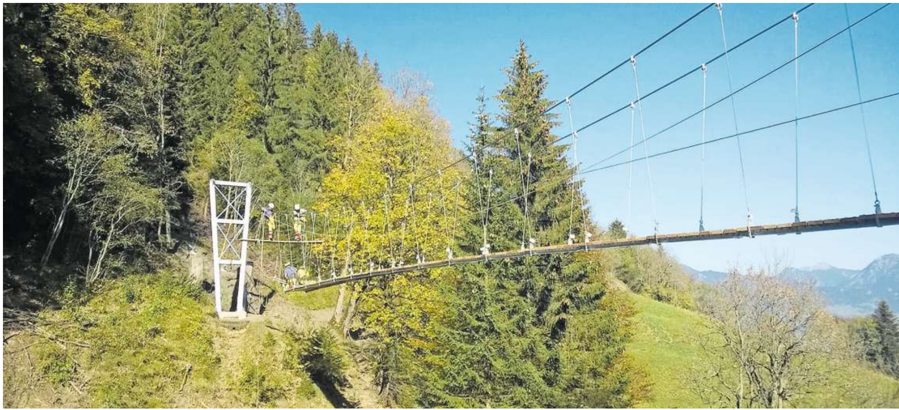
Derzeit wird die neue Hängebrücke erstellt. Sie befindet sich auf dem regionalen Wanderweg von der Bushaltestelle Schnapsgrotzen Richtung Berggasthaus Gonzen.
